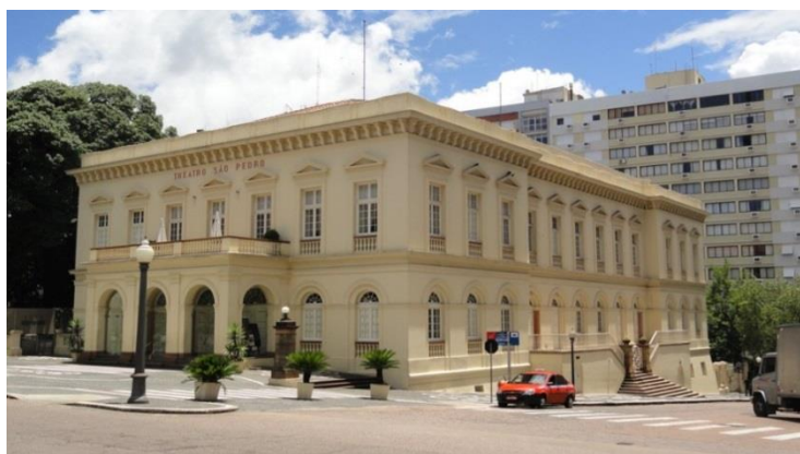
Figura 35 – Fachada do Theatro São Pedro (2023)
