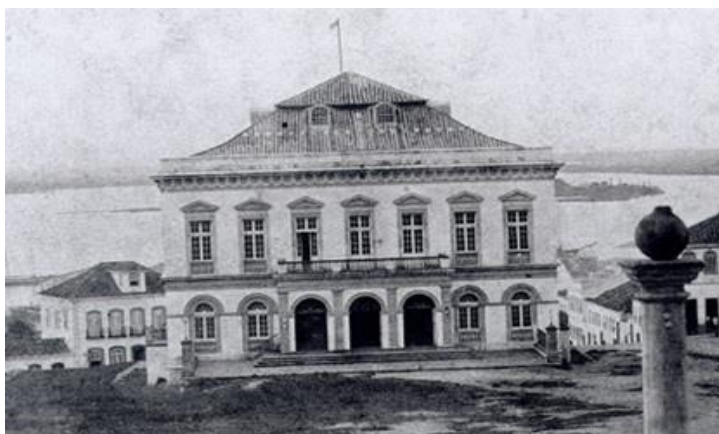
Figura 34 – Fachada do Theatro São Pedro
