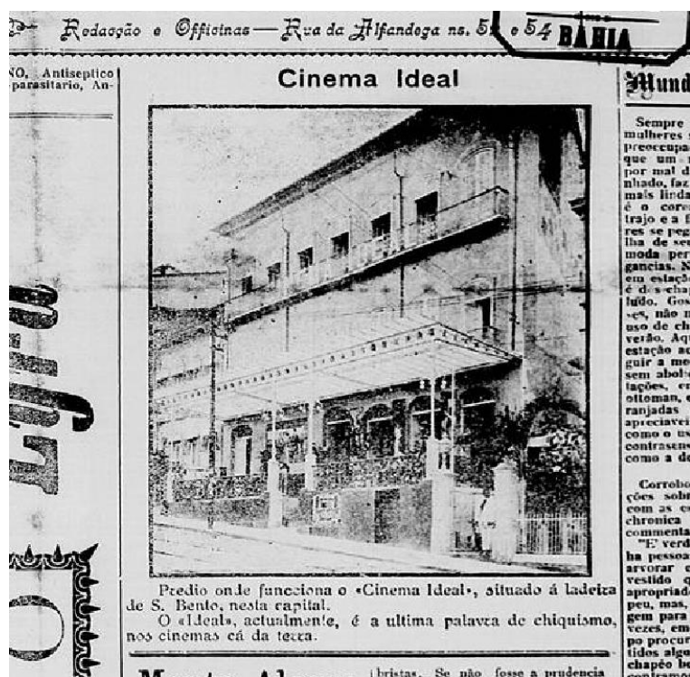
Figura 30 - Imagem da fachada do Cinema Ideal
