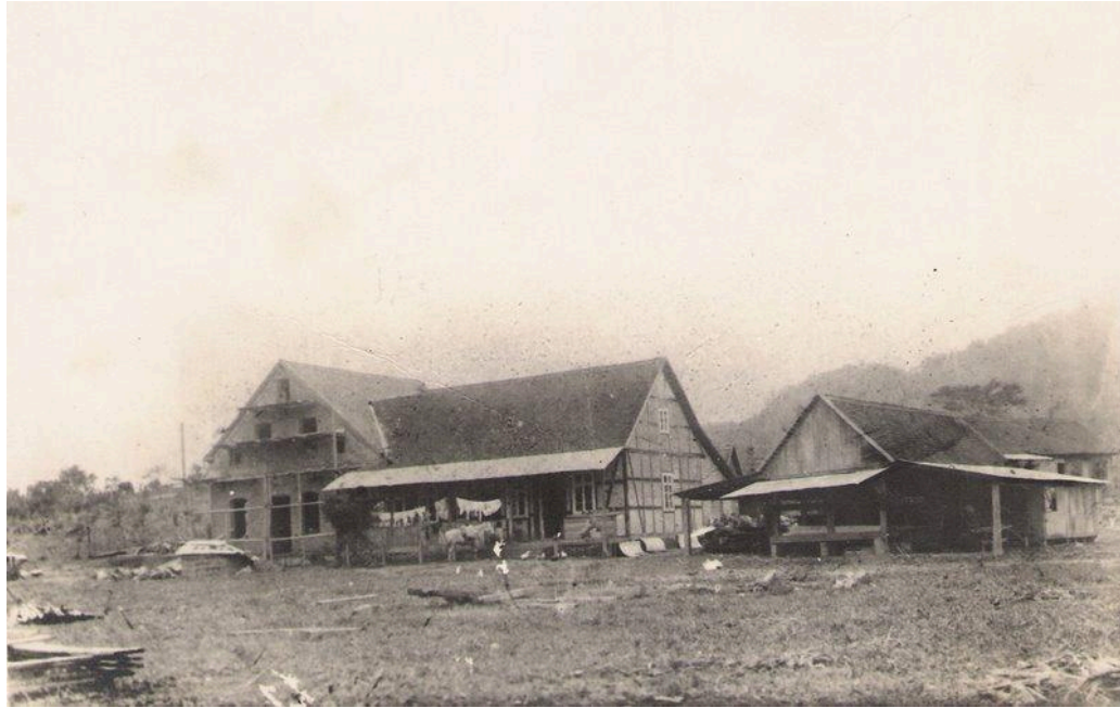
Figura 73 - Residência de Friedrich Weege
