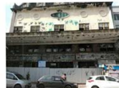
Tapumes na fachada do imóvel
