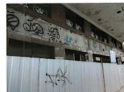
Tapumes na fachada do imóvel
