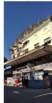
Obras em curso no prédio do Cine Guaraci
