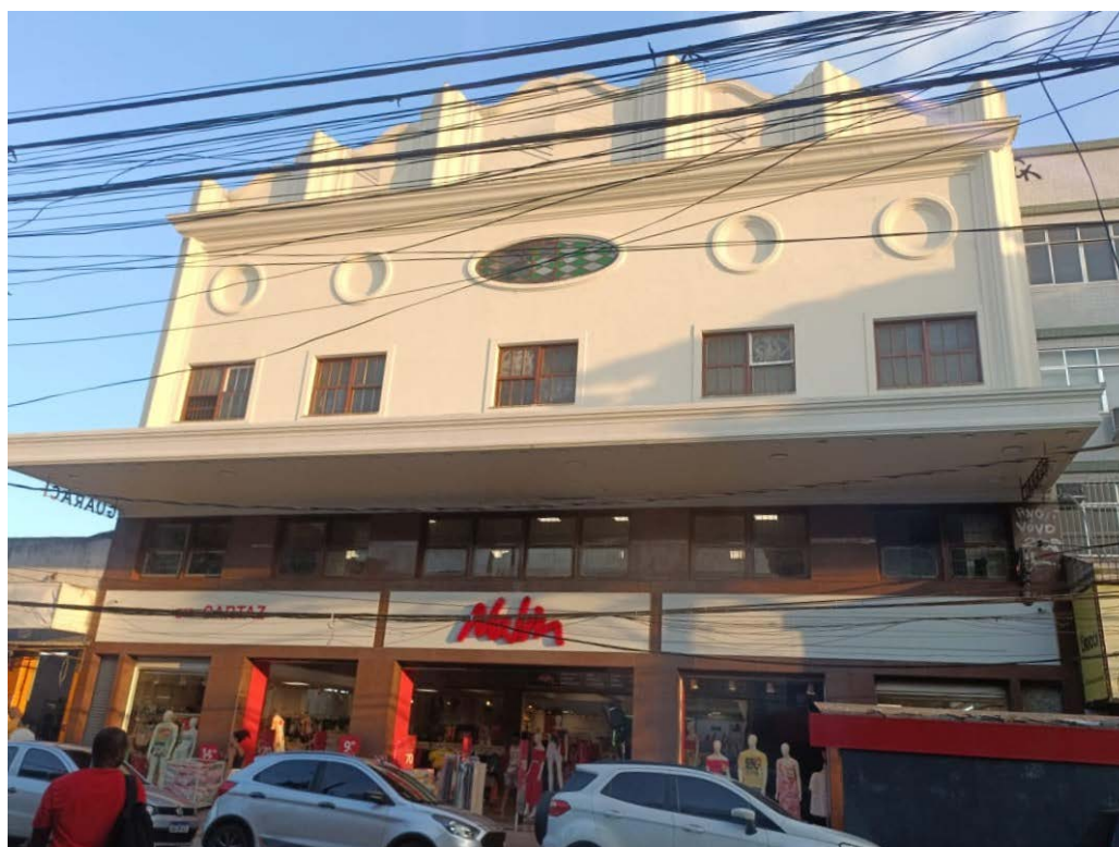
Figura 27: Fachada do Cine Guaraci após a abertura das Lojas Nalin
