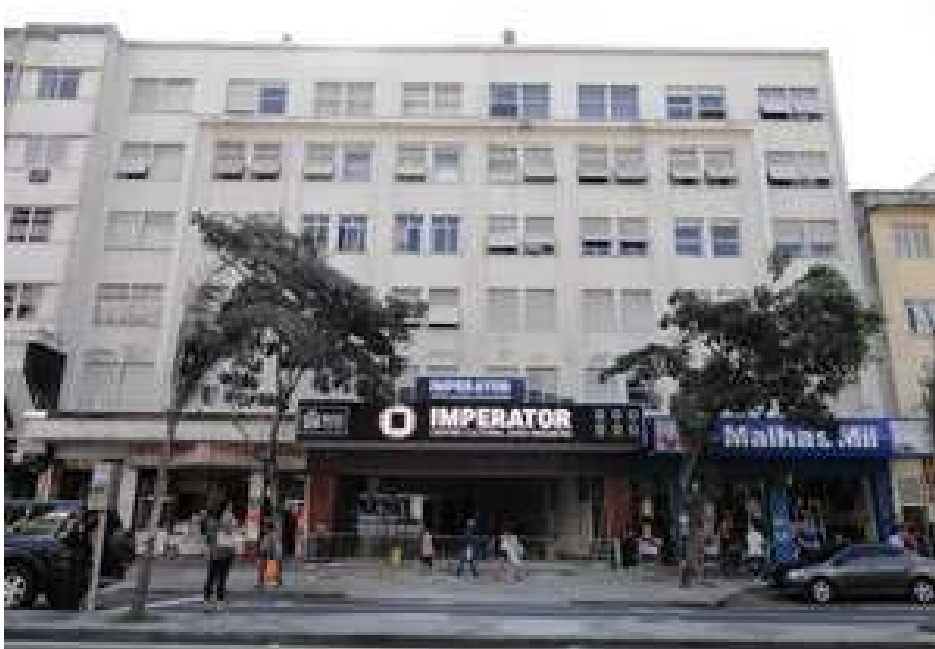
Figura 9: Foto da fachada do Centro Cultural João Nogueira
