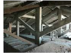
Telhado do lado esquerdo em montagem
