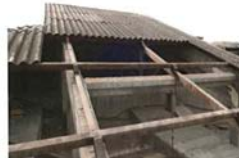
Telhado do lado direito à executar
