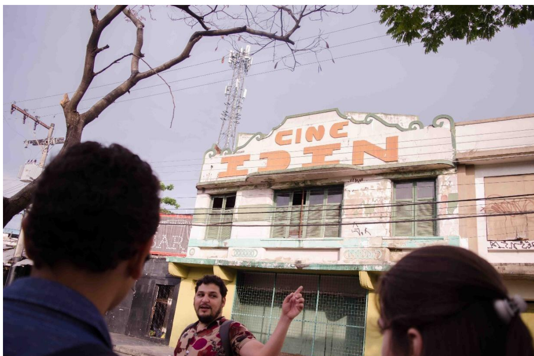
Fachada do Cine Éden, restaurada nos anos 2000 com o intuito de retomar suas atividades como centro cultural, não chegou a ser um projeto concretizado e hoje já apresenta sinais de deterioração novamente. Fonte: Centro Popular do Audiovisual.
