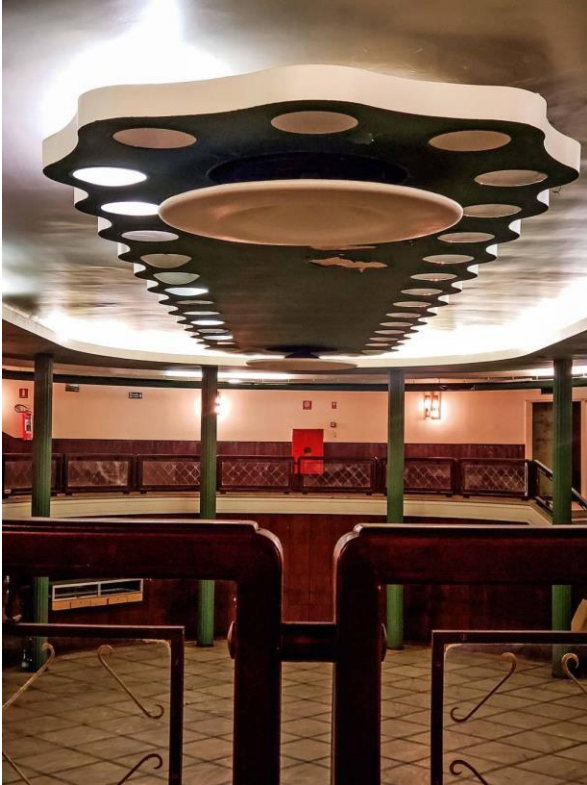
Figura 81 - Detalhes internos do Ipiranga. Disponível em: https://vejasp.abril.com.br/cidades/cinemas-abandonados-centro/
